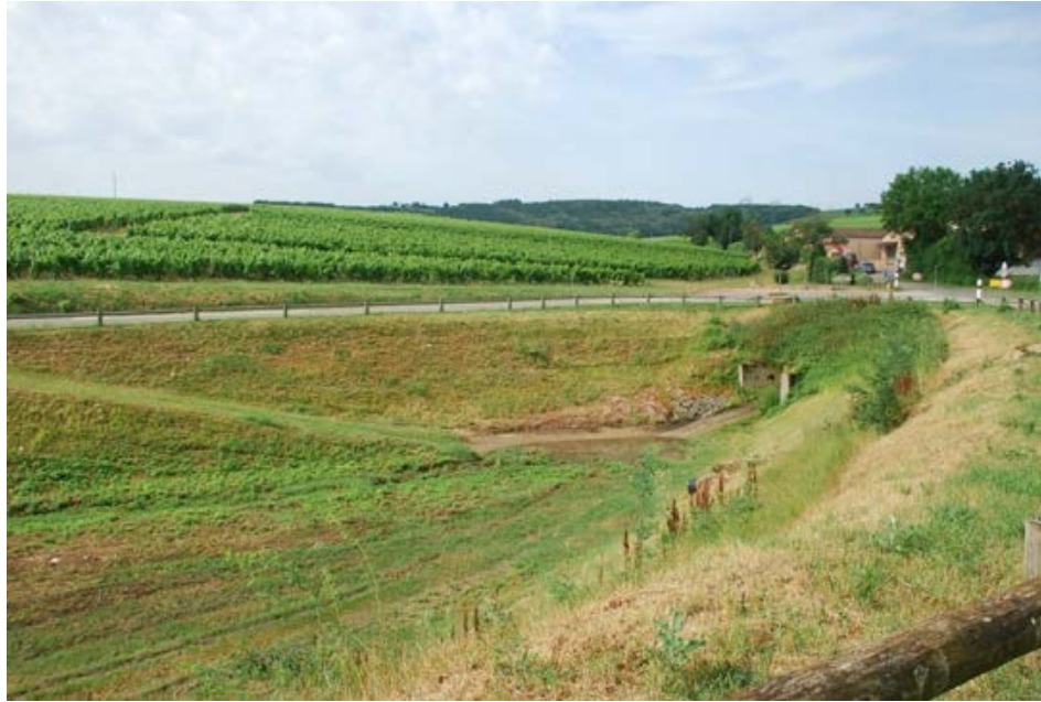
Bassin de rétention des eaux à Solentré-Pouilly
