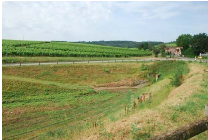
Photo 3 : bassin de gestion des eaux pluviales
